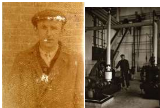
Gerardus (Grad) Sommerdijk in de machinekamer van de boterfabriek
